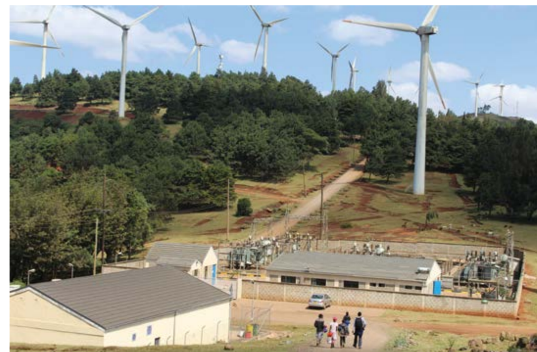
Parc éolien de Ngong Hills, Kenya
